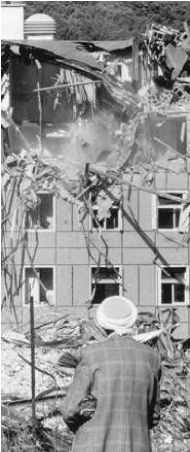
Destruction de la Cité de la Gare photo : Françoise Lacour, 1986
